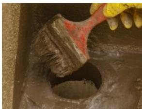
Nos ralos cobrir 40cm x 40 cm e 5cm na parte interna do tubo de PVC. (Sem tela estruturante)
