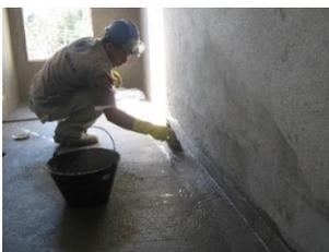
**PASSO 2:** Fazer a aplicação com pincel, trincha, rolo ou desempenadeira de aço lado liso começando pelos cantos;
