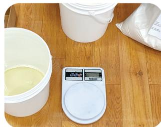
2) Agite bastante a lata ou galão de resina e endurecedor e calcule a quantidade que você precisará de cada item, conforme boletim técnico. Depois pese todos os componentes.
