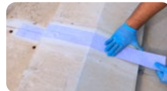
Sobreposição de chapas com Flexfelt Autoadesiva
